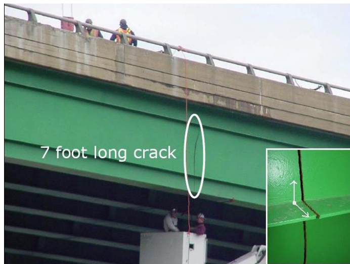
(d) Welded cover plates.
